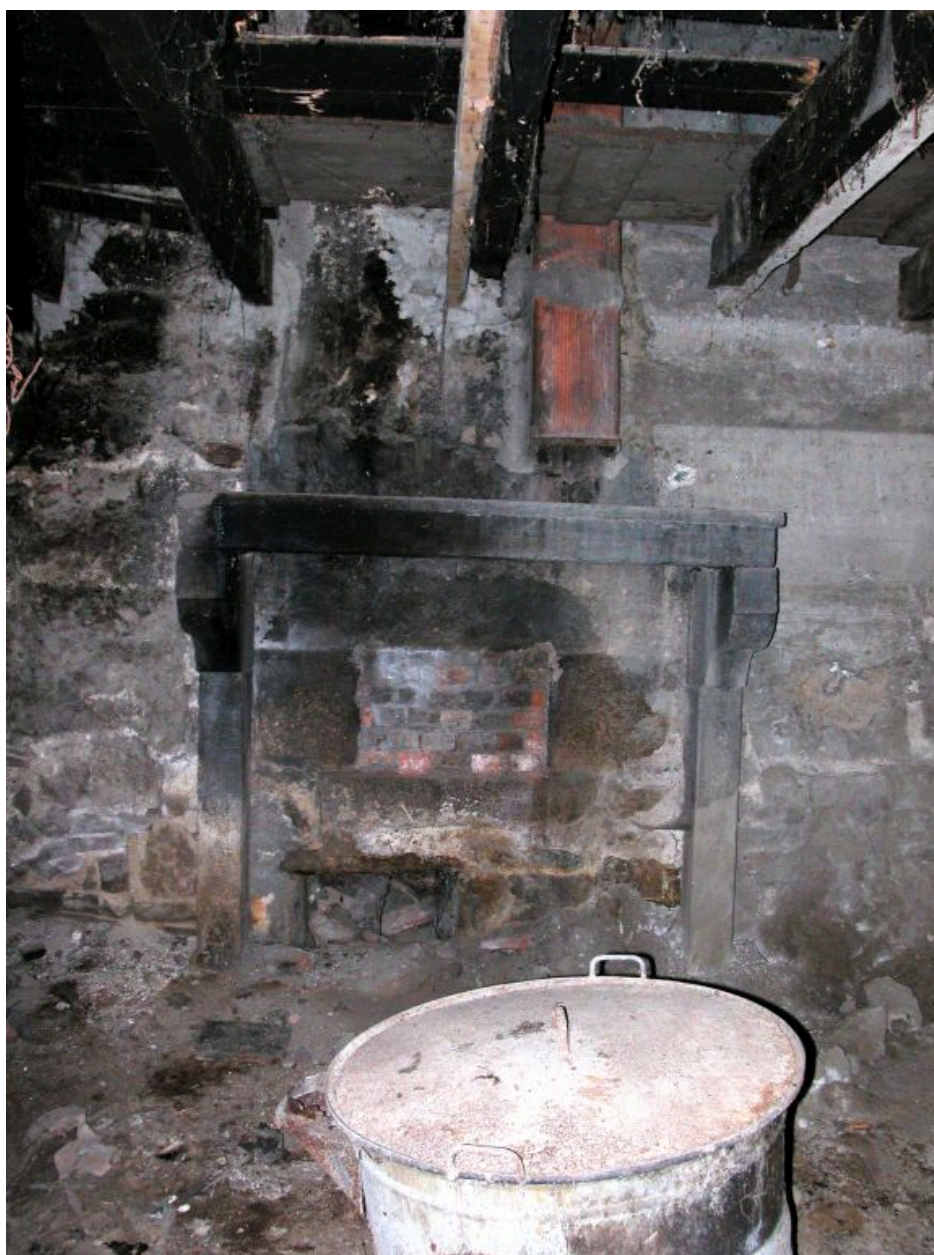
Cheminée de la cuisine de l'ancien logis de la ferme AO 35.
