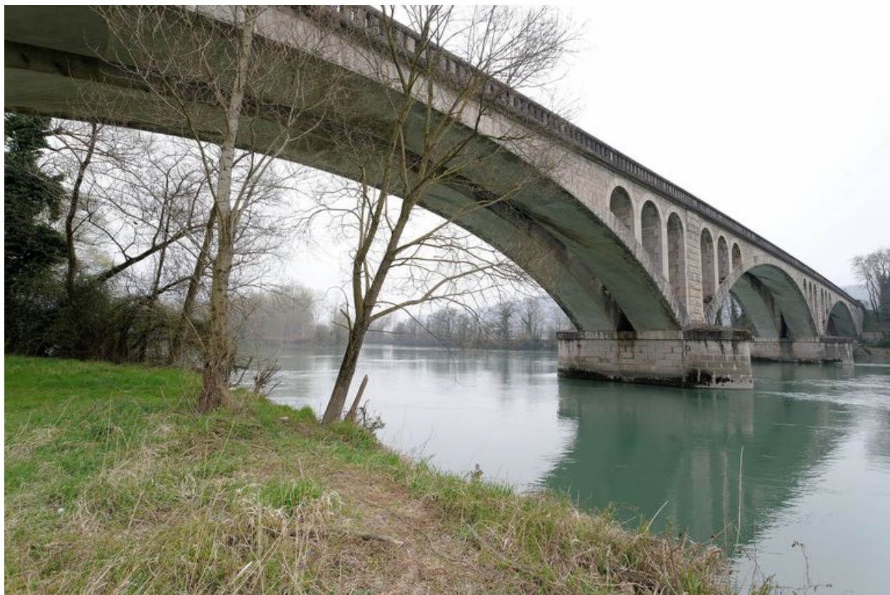
Vue côté aval, depuis la rive droite
