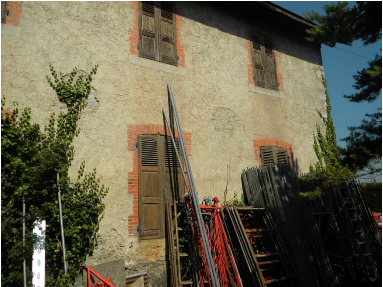
Détail d'une façade avec les encadrements en briques.
