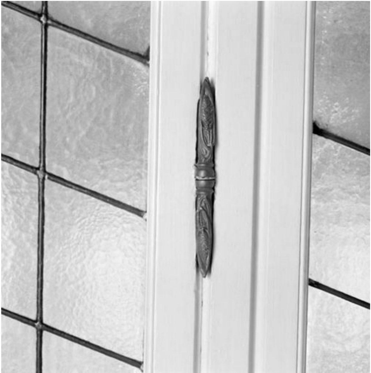
Fenêtre éclairant la cage d'escalier : détail des gonds
