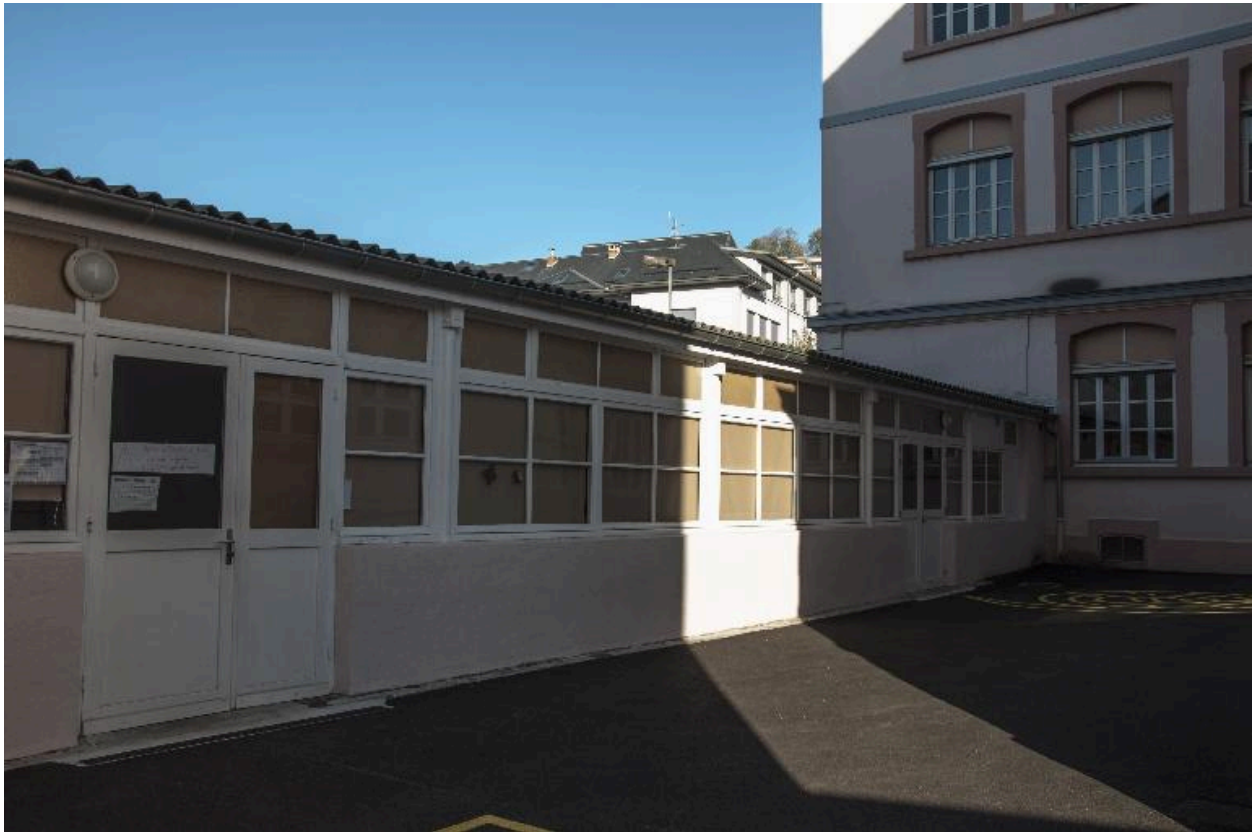
Corps de bâtiment, angle nord-ouest
