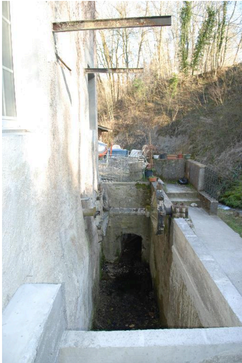
Moulin amont, emplacement ancien de la roue à aube, sens aval.
