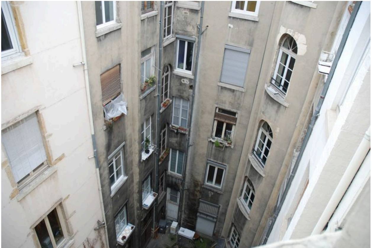
Vue partielle de l'élévation postérieure, occultée à mi-façade par le retour postérieur du 4 rue Béchevelin
