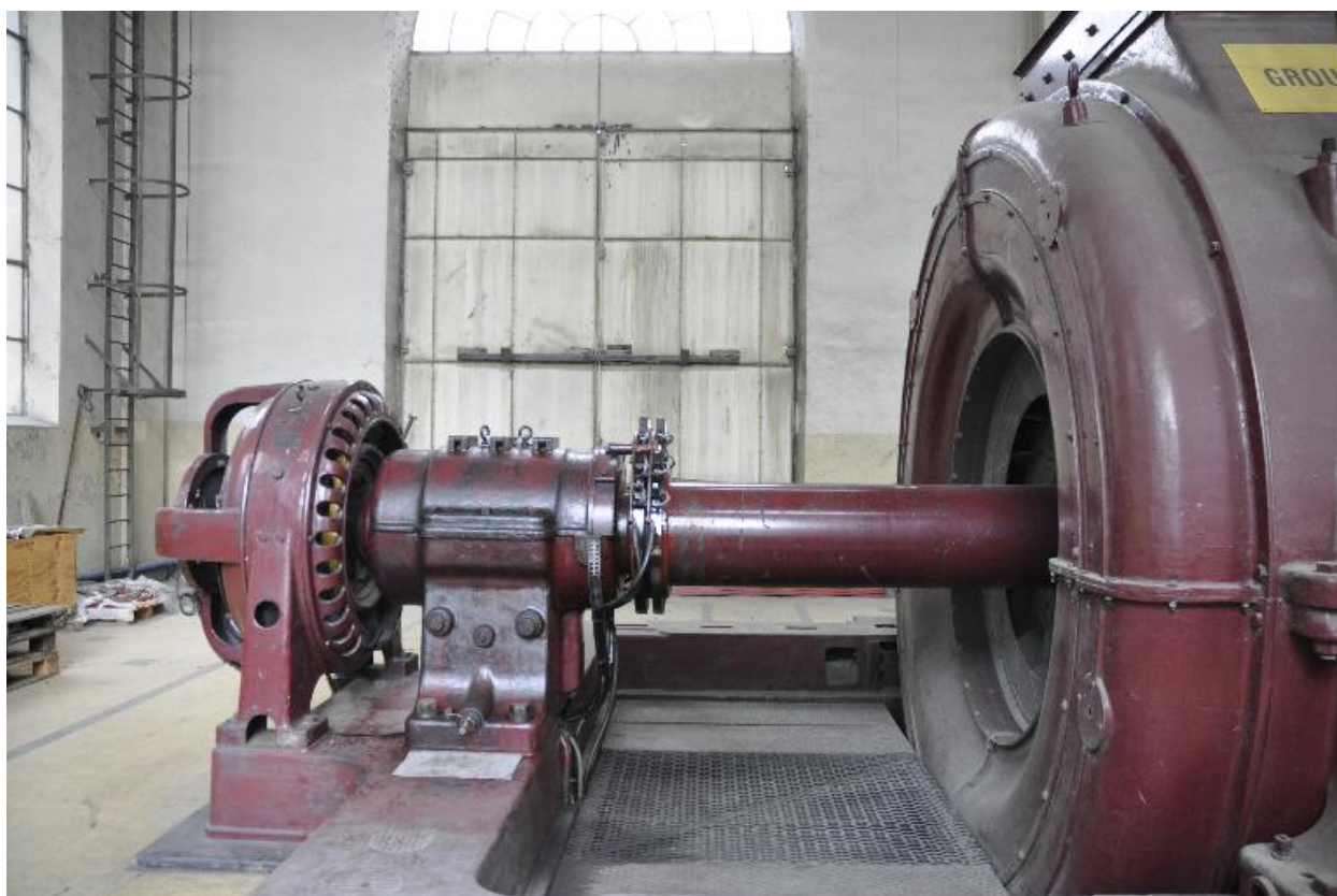
Détail : exitatrice, arbre, alternateur
