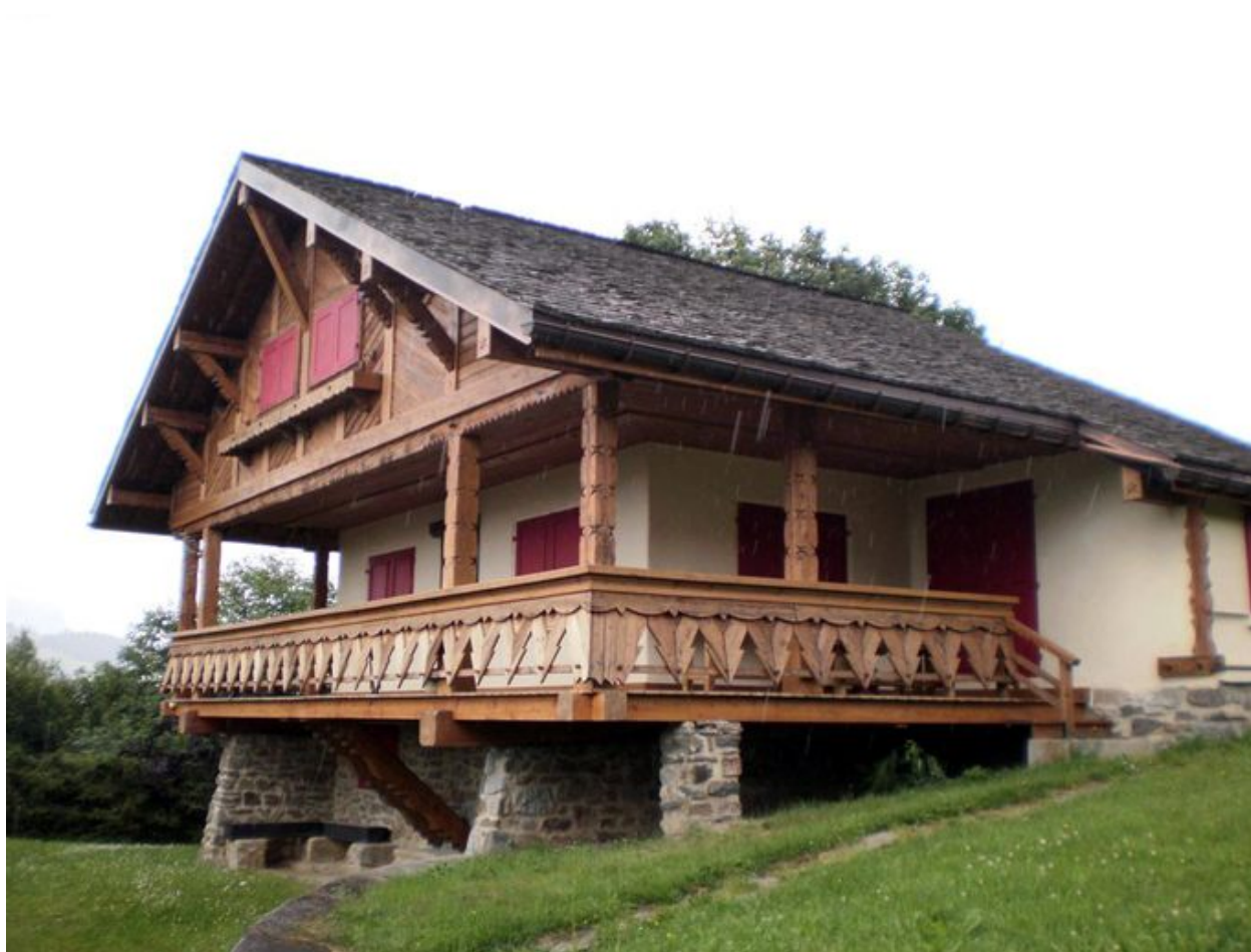
Vue d'ensemble. Etat en 2009
