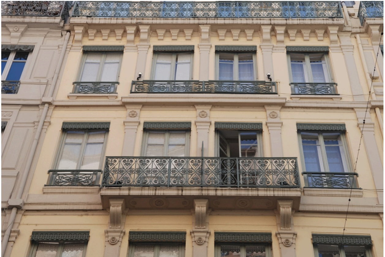
Élévation antérieure : vue partielle
