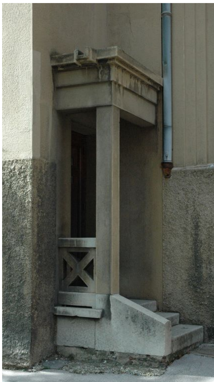
L'escalier construit à l'angle sud-ouest du transept
