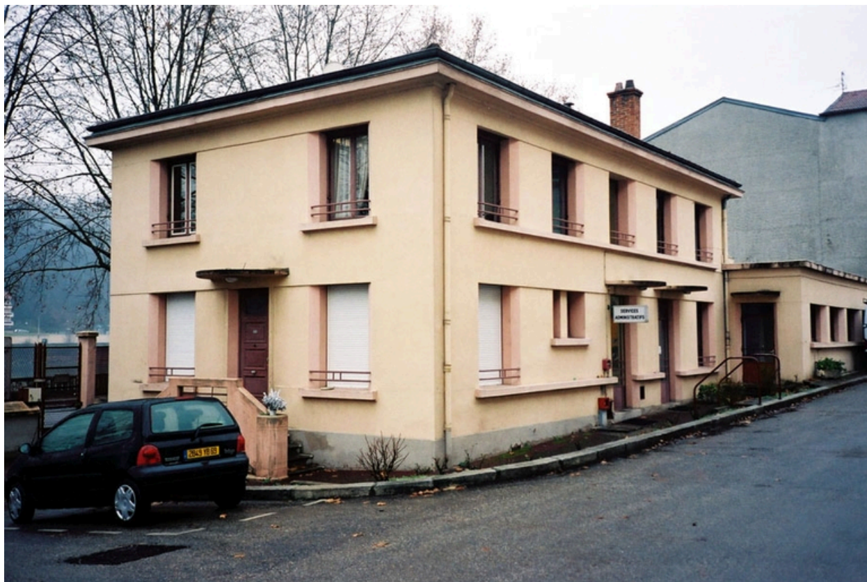
Vue ouest, pavillon d'entrée
