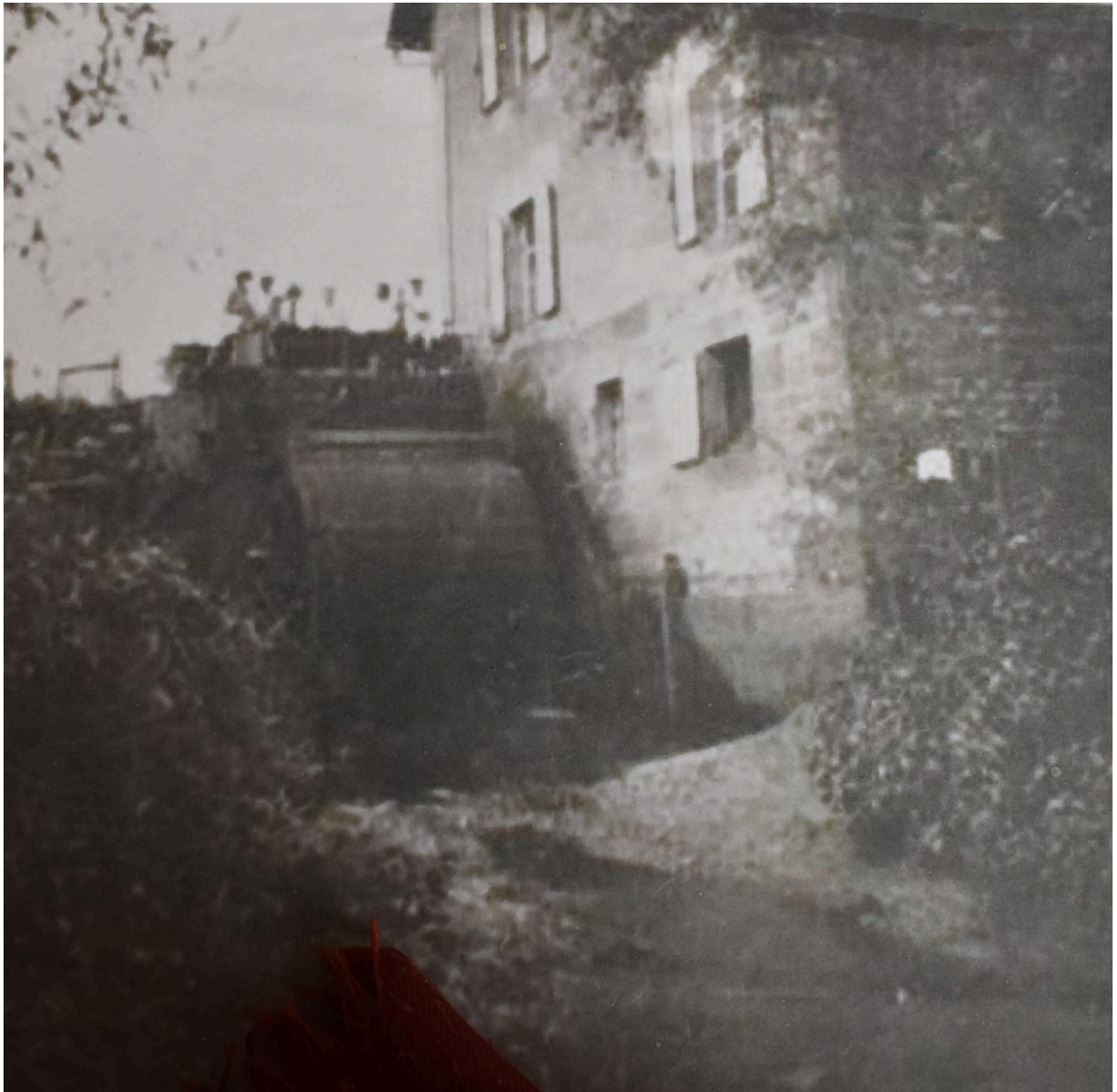
Le Moulin Neuf en 1937 : détail de la roue (Sagebien?) avant son remplacement par une turbine.
