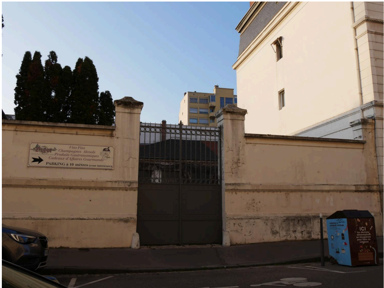
Portail et enseigne commerciale
