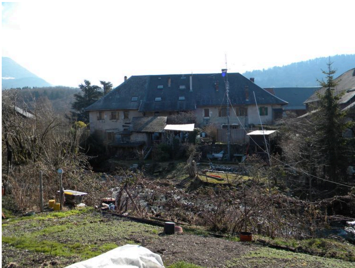
Vue de la façade arrière.
