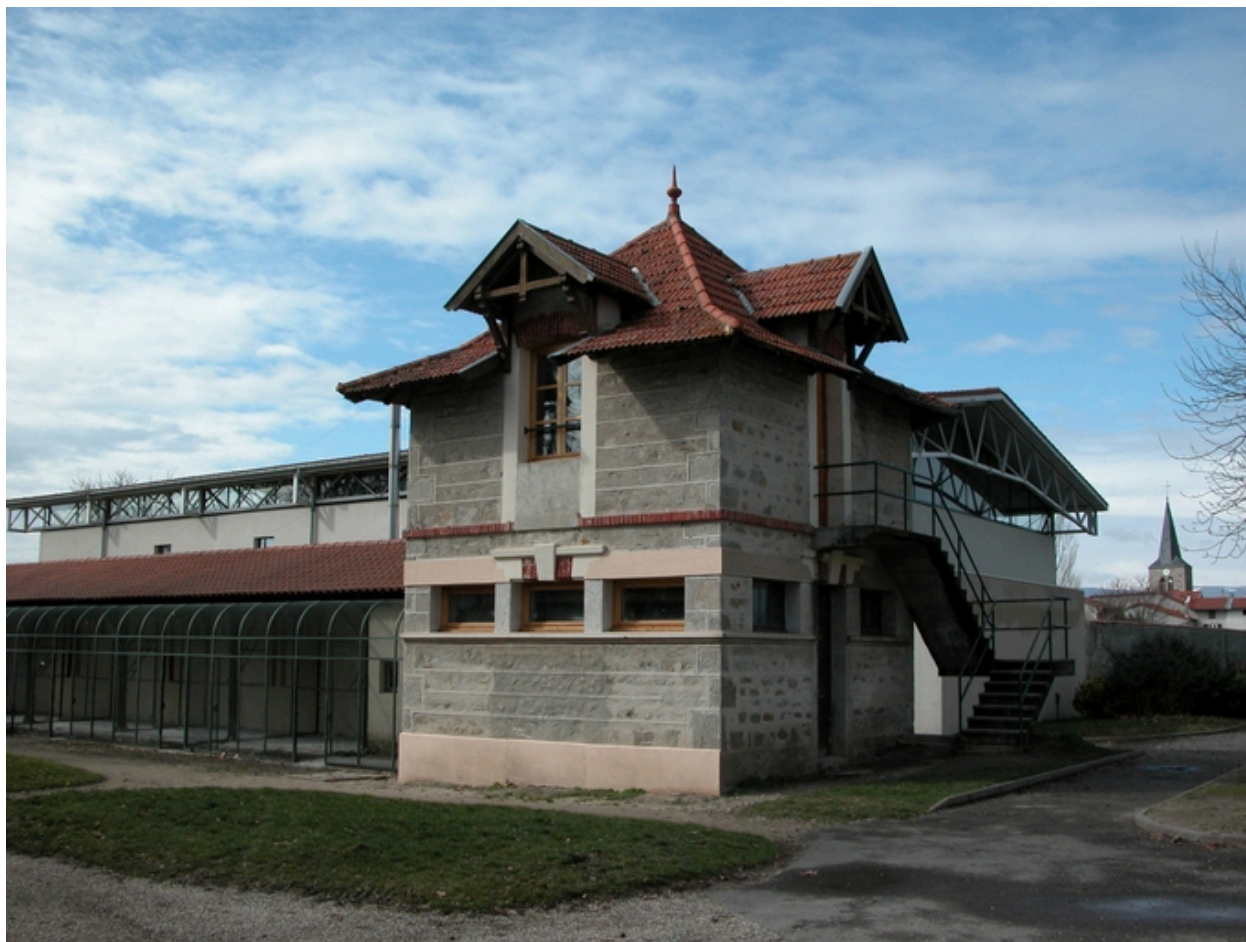
Vue du pavillon de douches et logement au nord de la volière.
