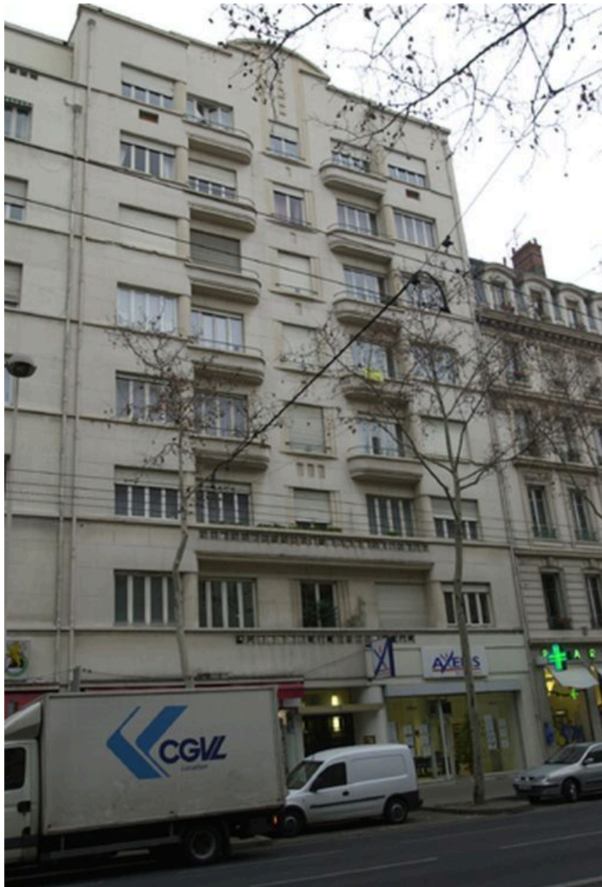
Vue générale de l'élévation sur rue
