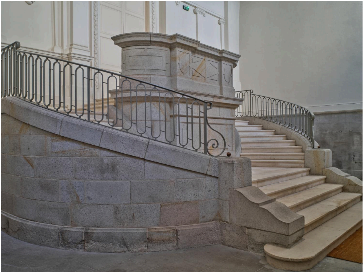
Vestibule, détail de l'escalier
