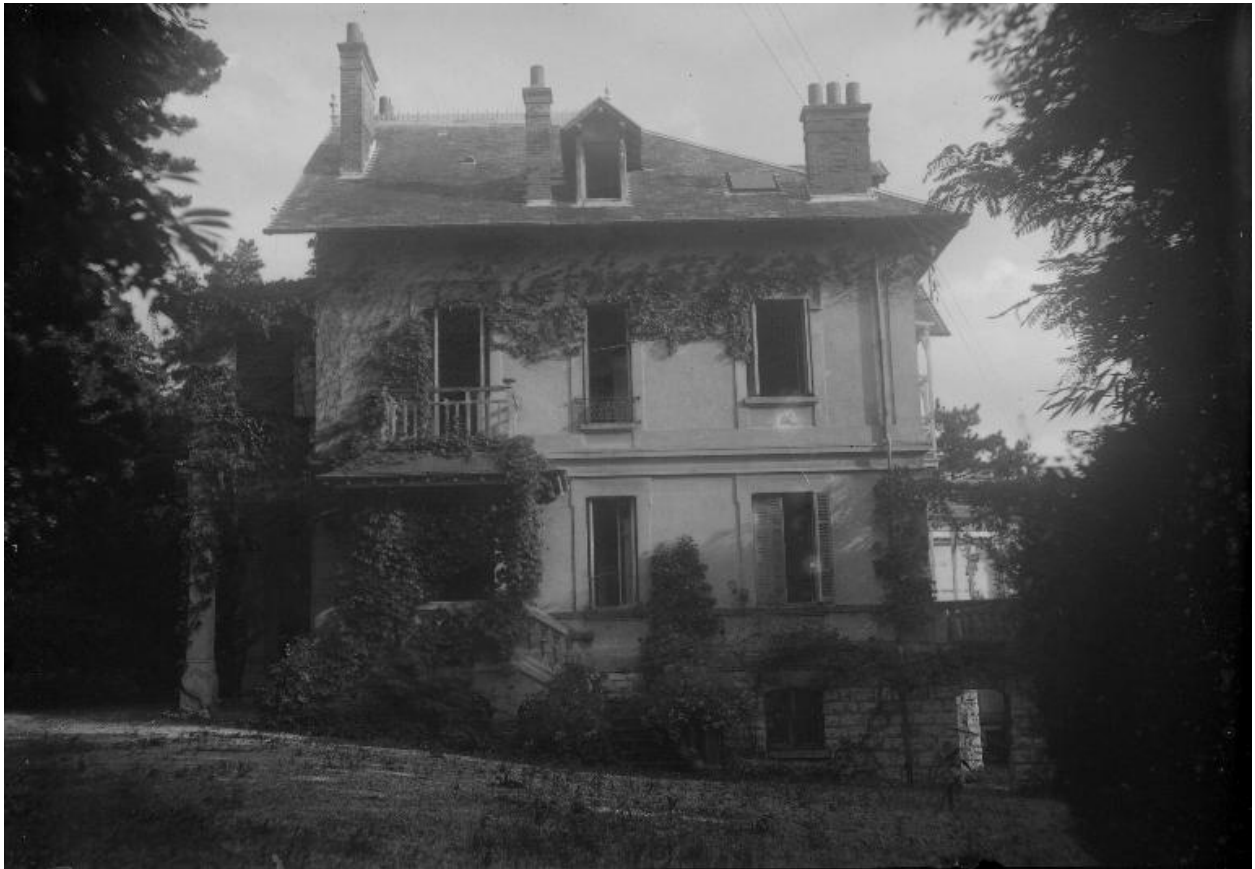
Façade nord, vers 1930
