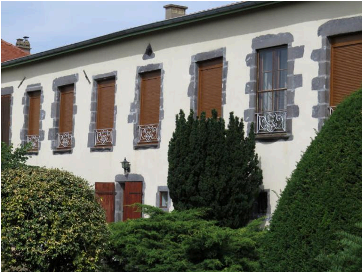
Vue partielle de la façade sur jardin
