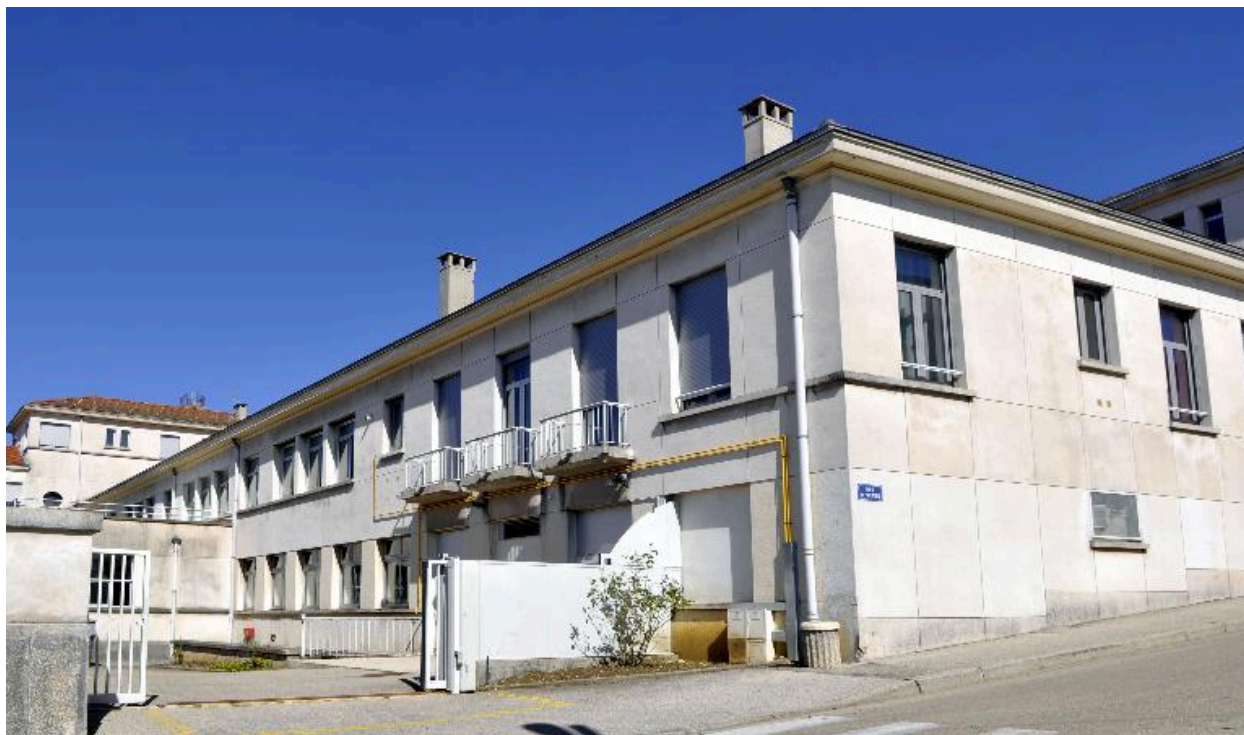
Bâtiment E, depuis l'ouest
