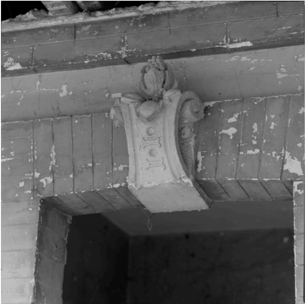
Aile gauche des bains - douches, détail d'une clef d'arc d'une des cabines.
