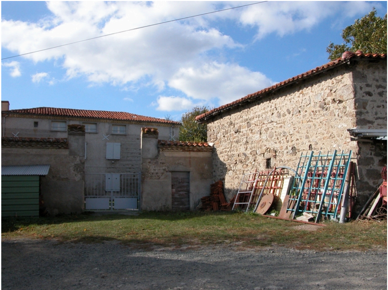
Vue de l'entrée de la cour et du bâtiment de communs, du sud-est.
