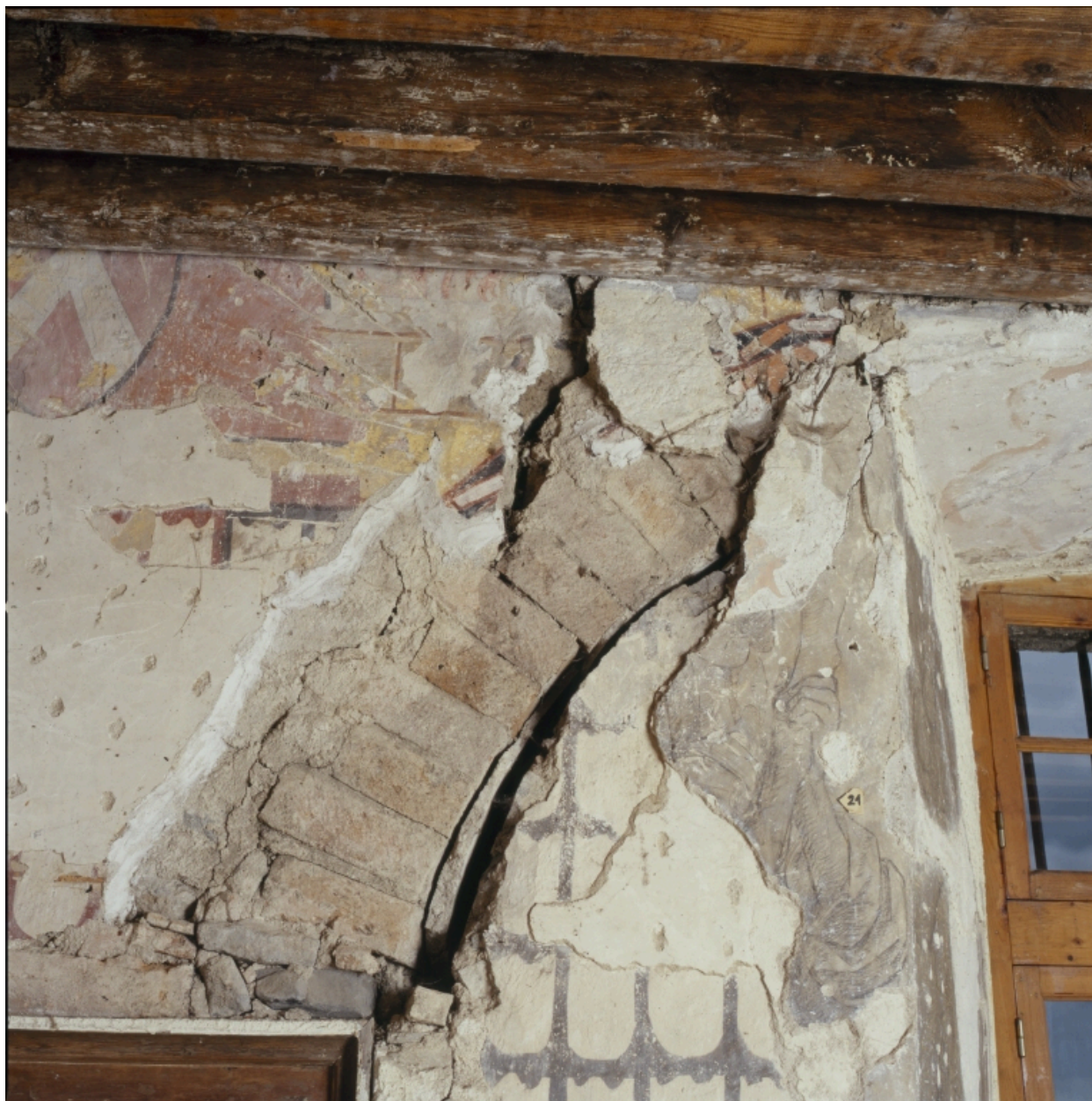
Voûte en brique et enduit du 12e siècle (décors muraux successifs de la salle du premier étage du logis prieural).
