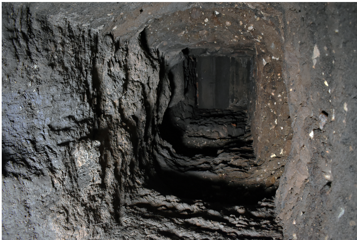
Caves nord, salle n°16 : soupirail à l'extrémité nord communiquant avec la salle n°13 au niveau -1
