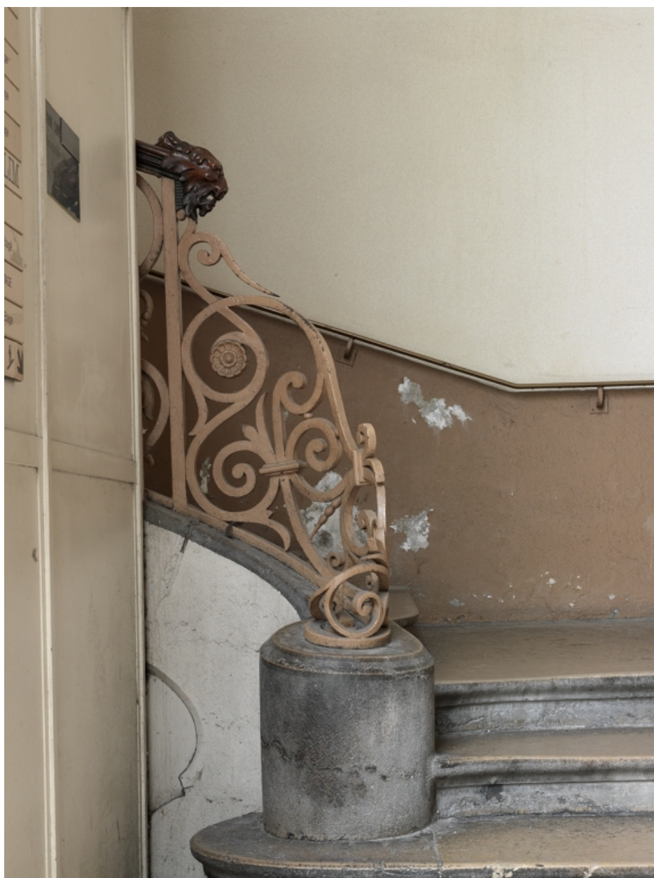
Bâtiment K. Le départ de l'escalier nord
