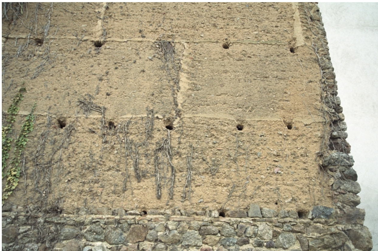
Débats-Rivière-d'Orpra, Ligeay, grange (1987 A1 703). Détail du pisé de l'élévation postérieure, partie droite (17 e siècle ?).
