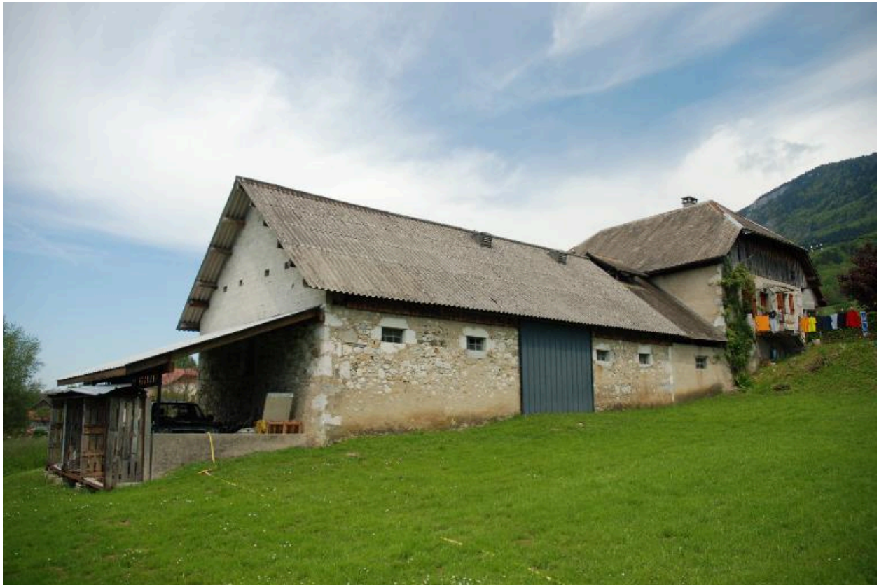
Vue d'ensemble de la porcherie, face sud.
