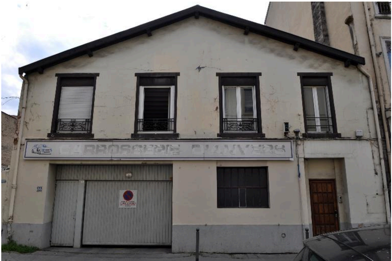
Atelier, vue de l'élévation sur rue
