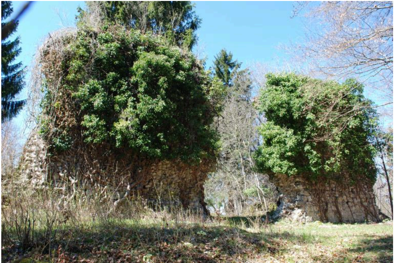
Château. Vue d'ensemble extérieure de l'élévation est des murs, entrée du château (?)
