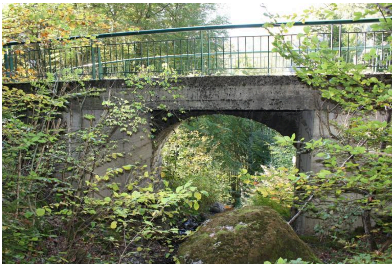
Pont de Bellecombe, face amont
