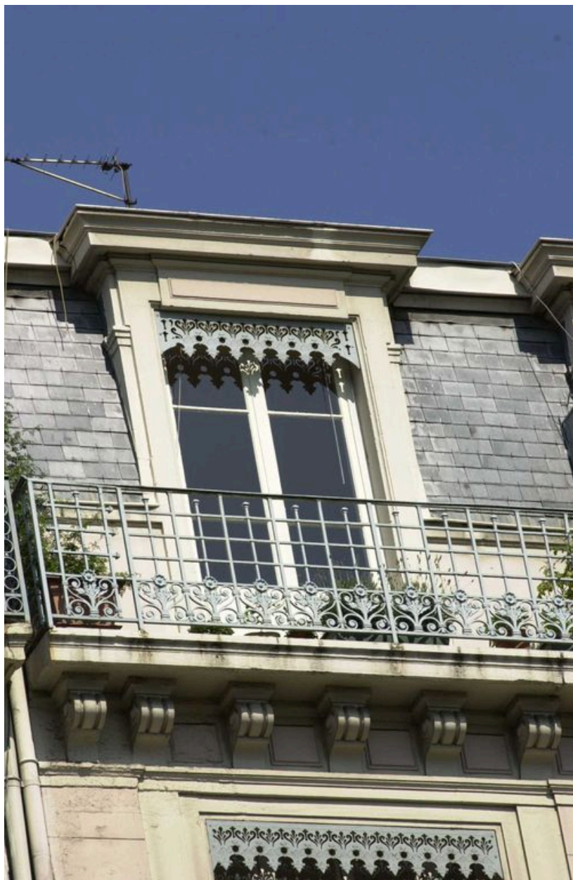
Fenêtre et garde-corps du balcon de l'étage de comble
