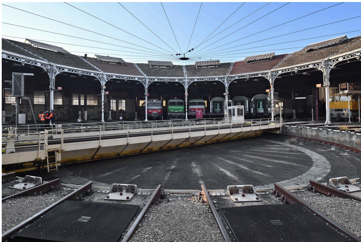
Vue intérieure de la rotonde de la Mouche à Gerland
