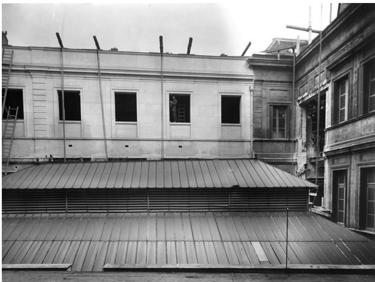
Vue de la verrière, lors du chantier d'aménagement de l'escalier des bureaux, en 1921-1922 (Banque de France, PHAR, non coté, photographie).
