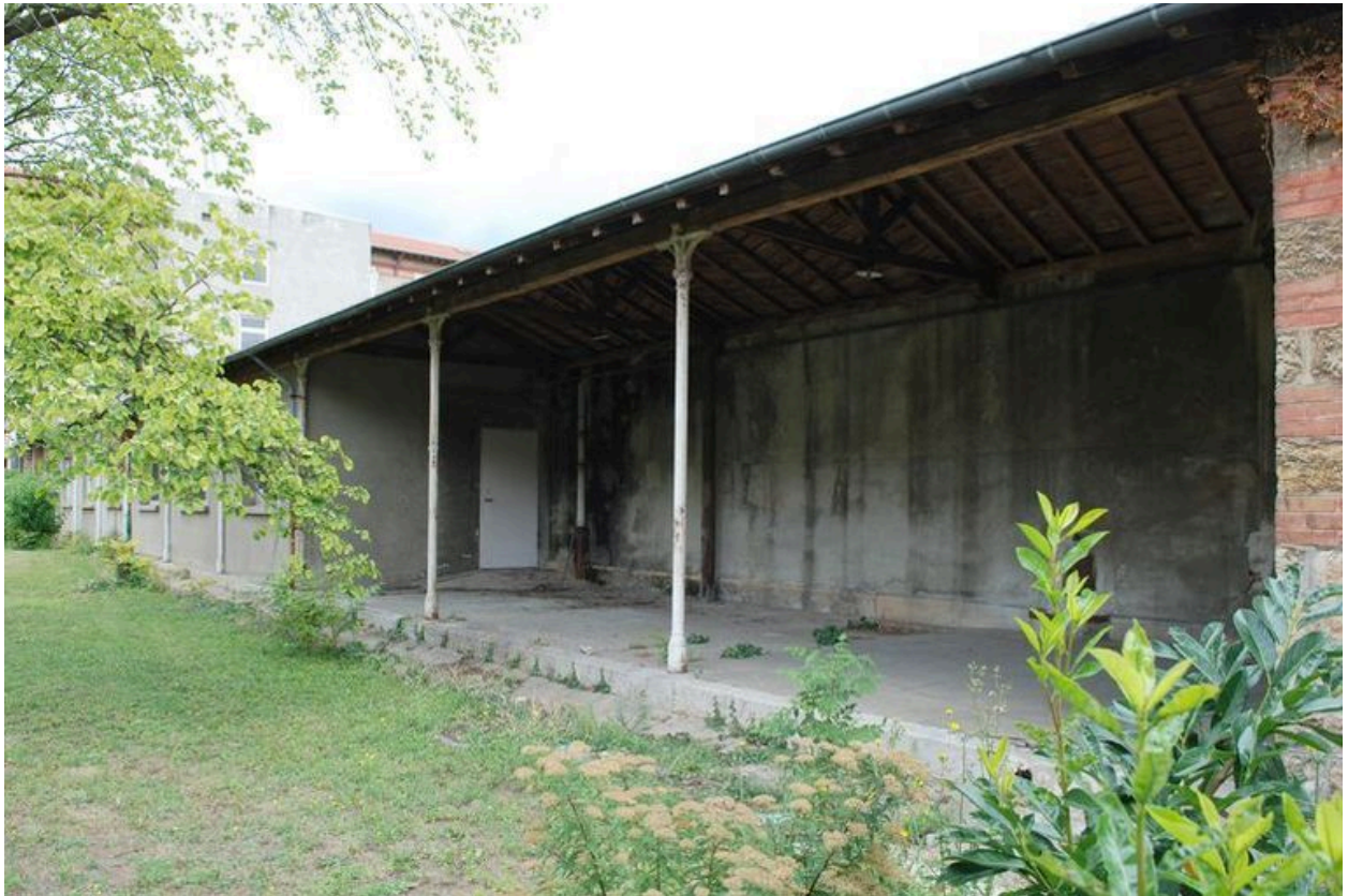
Promenoir, partie sud-est : colonnettes en fonte et piliers en briques et moellons d'origine
