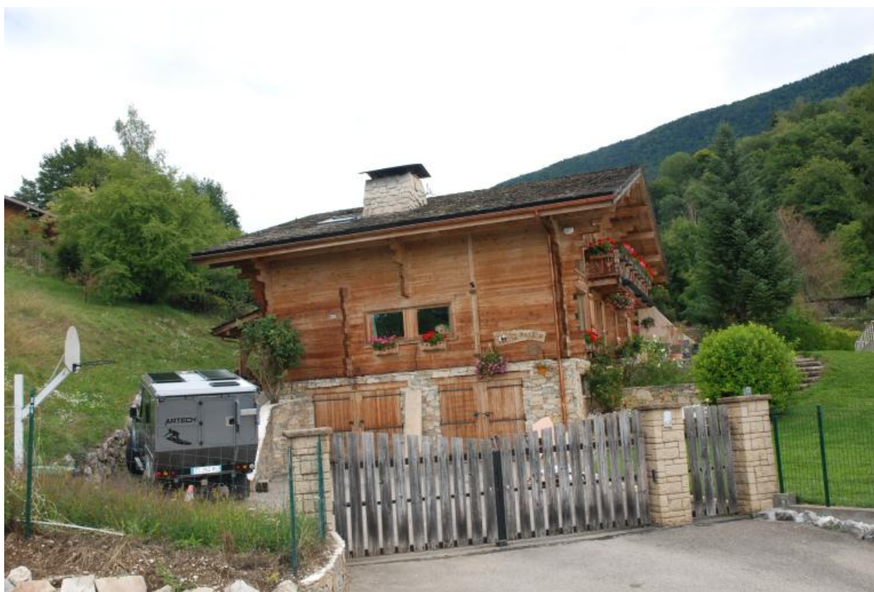
2016 C7 1582, Chez Jacquier, maison. Maison de type chalet, vue d'ensemble du côté gauche.
