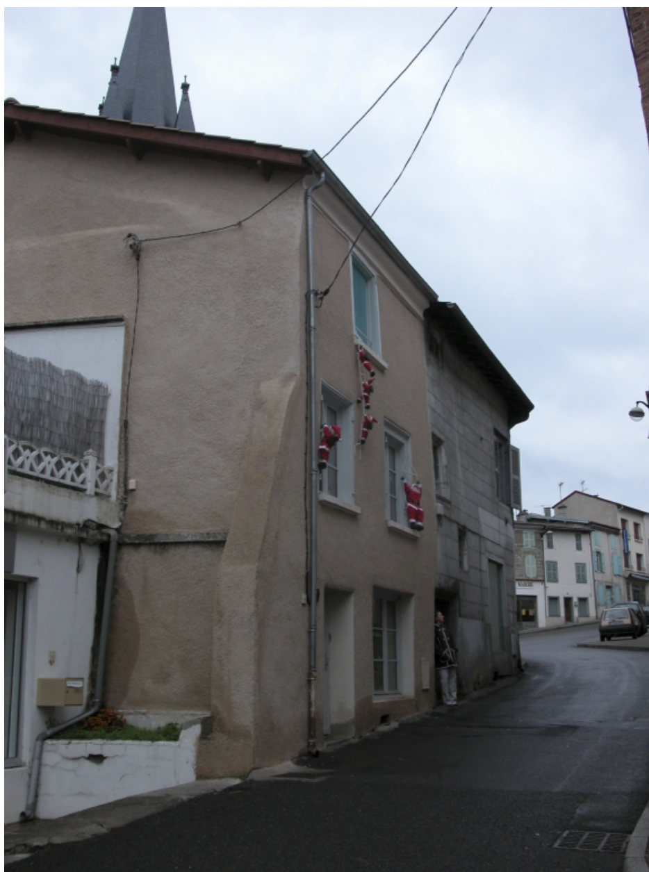
Îlot 10. 8 Mai 1945 (rue du) 03. Vue générale de la façade sur rue.
