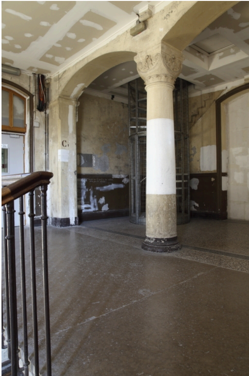
Escalier de desserte des niveaux supérieurs.
