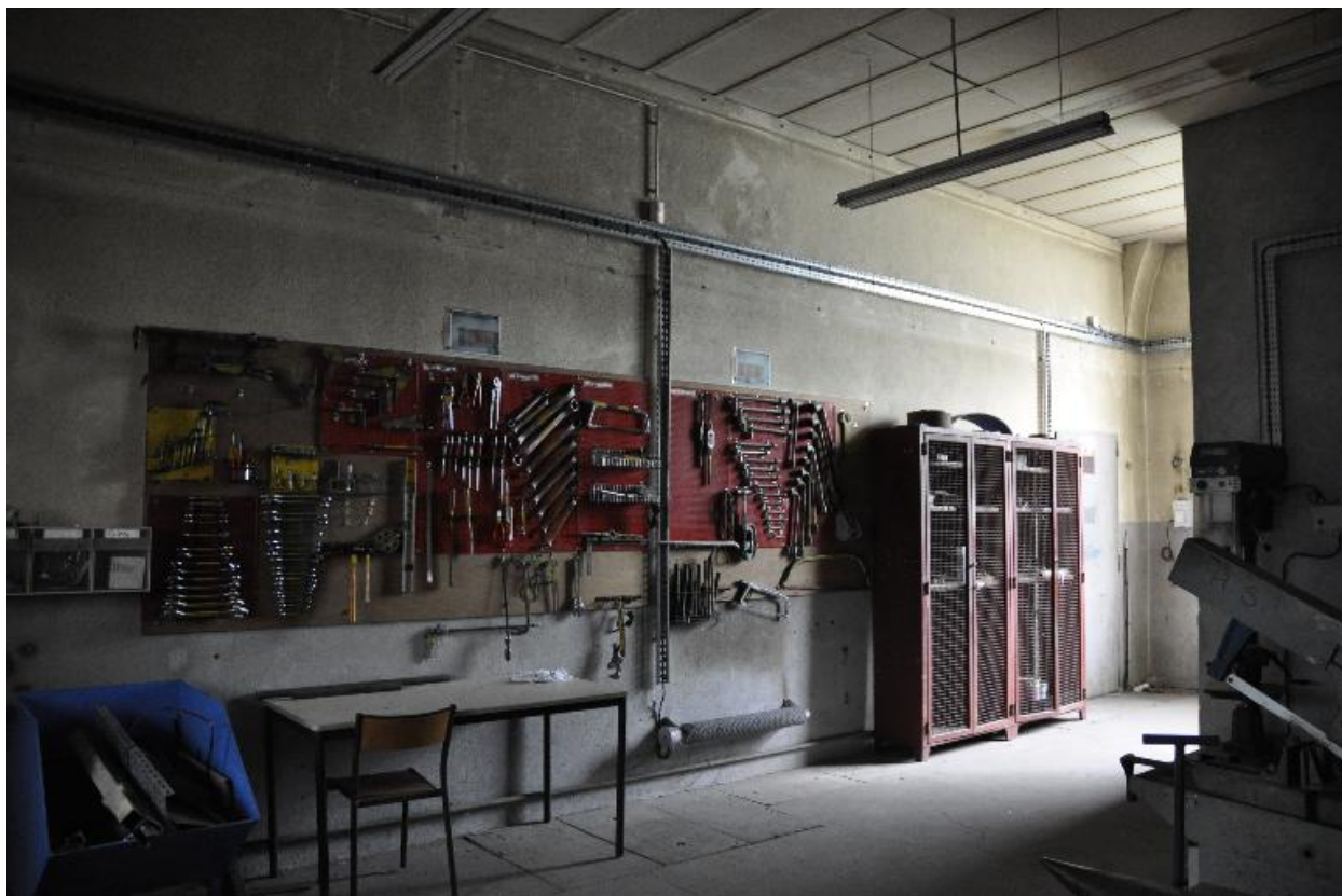
Vue de l'atelier mécanique de la centrale
