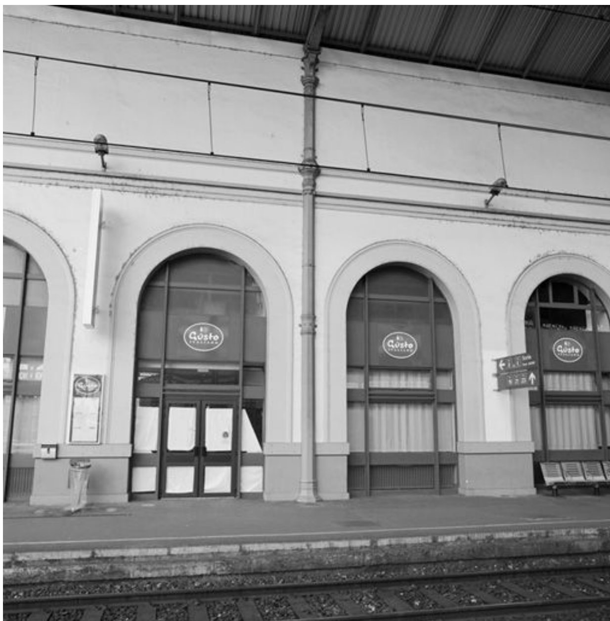
L'une des colonnes en fonte supportant la grande halle
