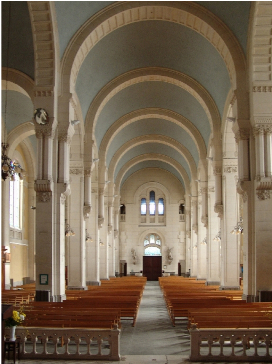
Nef vue depuis le chœur
