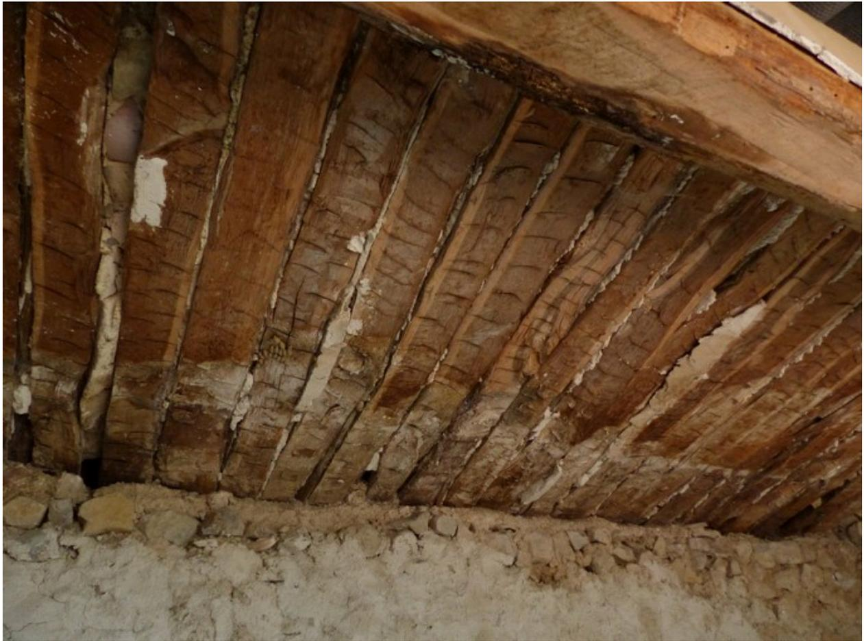
Charpente à pannes, et quarts sur lesquels sont maçonnées les tuiles. Ferme au quartier de Bigonnet.
