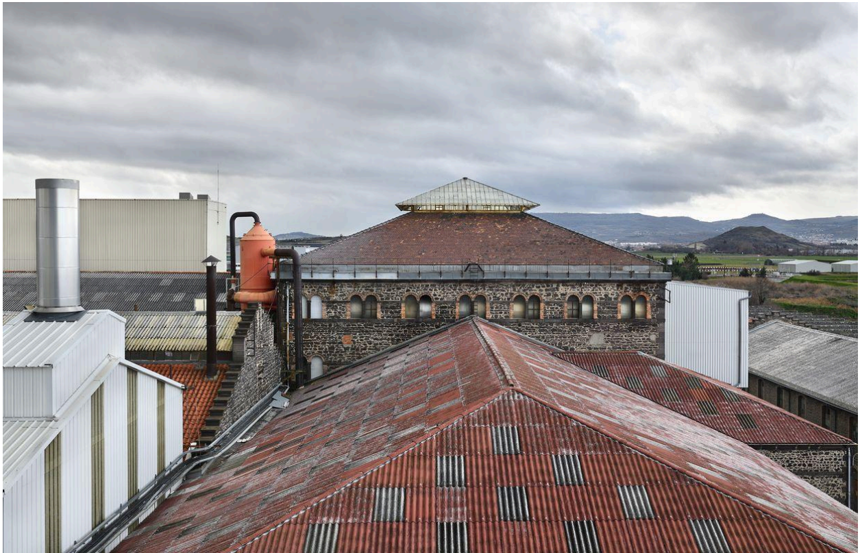
Vue des toitures : lanterneau avec un condenseur barométrique sur la gauche
