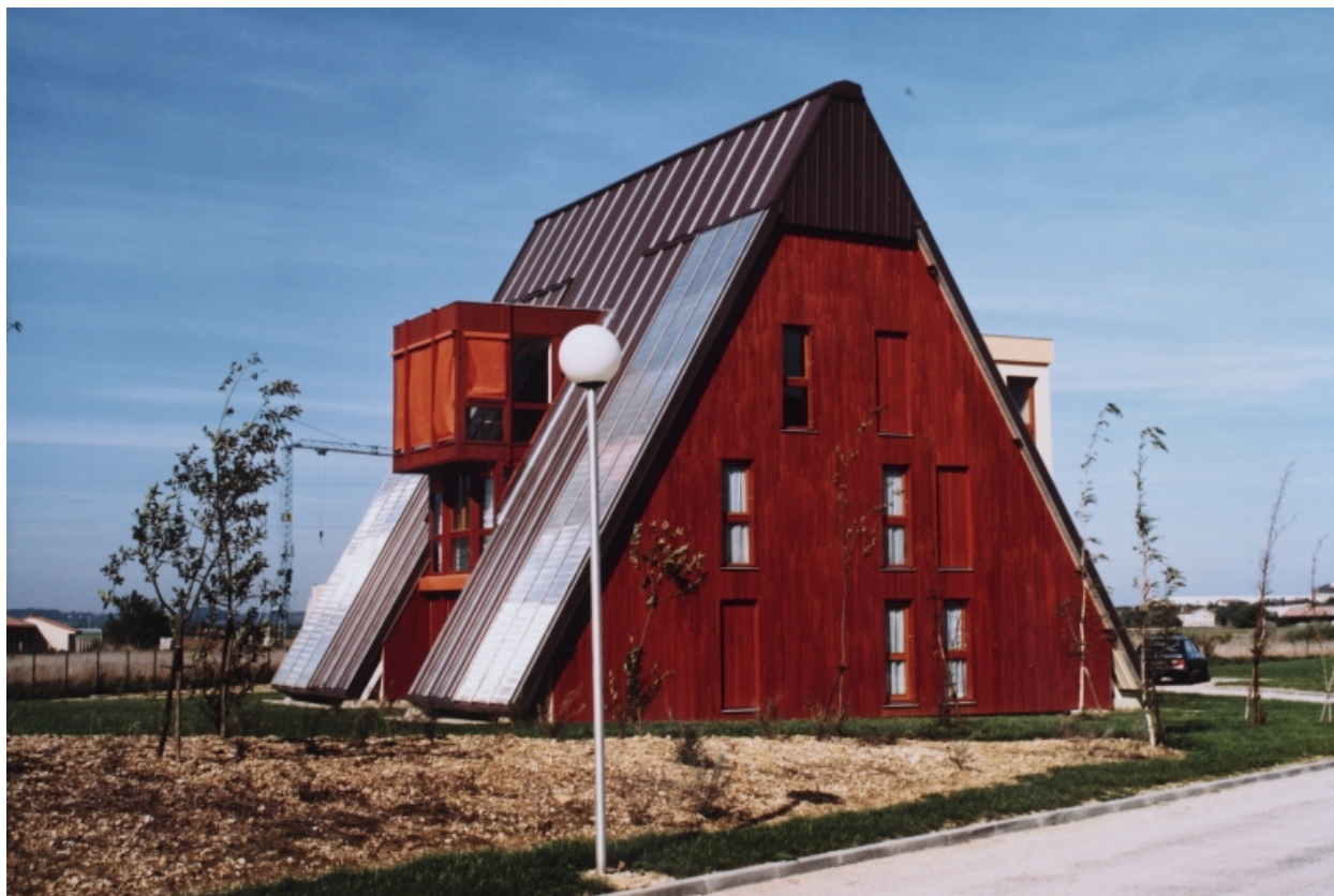
Album de la construction. Le bâtiment d'appartements de fonction achevé. 1983.
