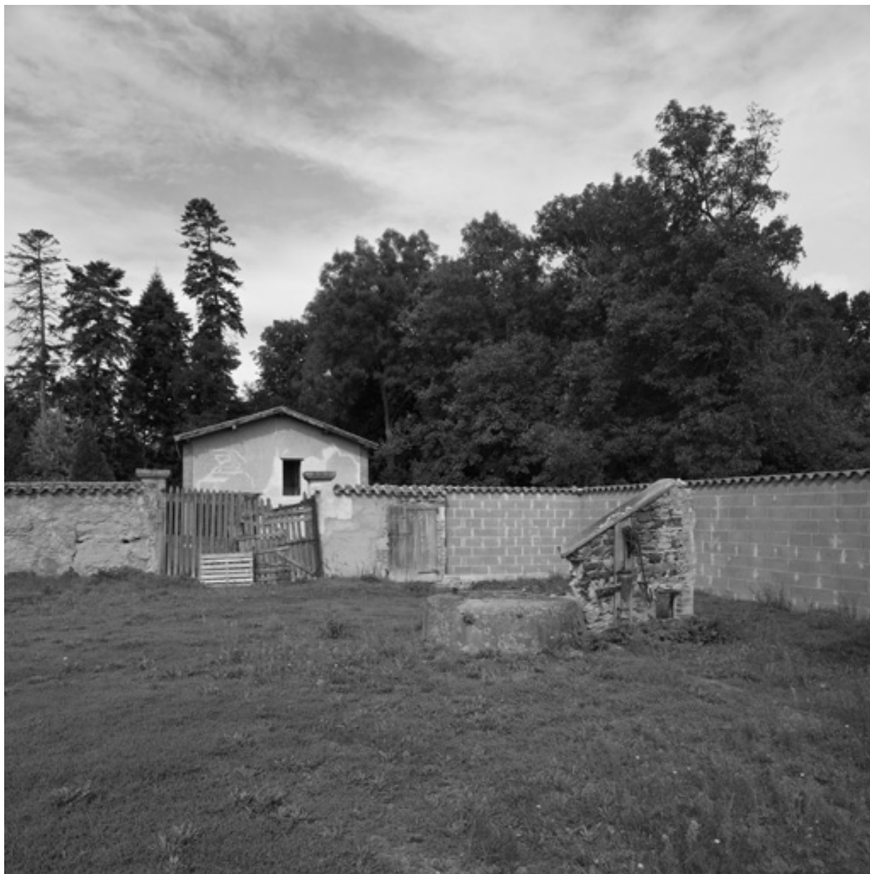
Vue de l'angle nord-ouest de la basse-cour nord : emplacement du pigeonnier et du poulailler détruits (mur de clôture remonté en parpaing de ciment), cuvage à l'arrière-plan.
