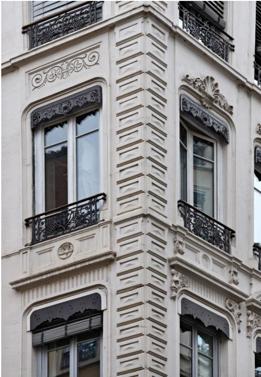
Rue de Brest et Ferrandière : traitement de l'angle
