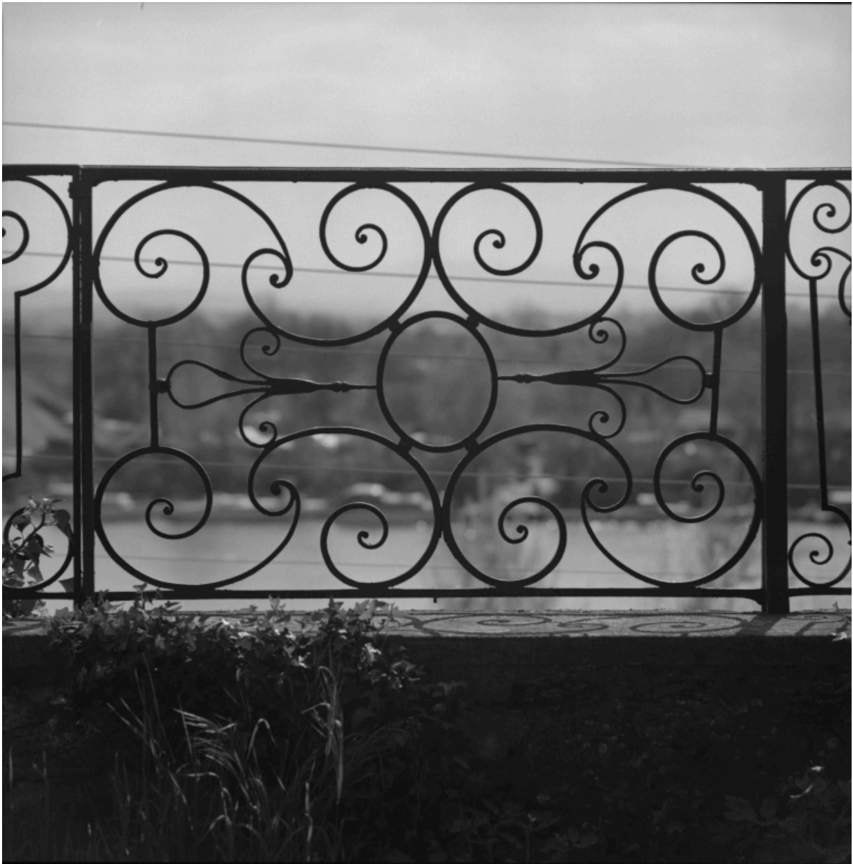
Garde-corps de la terrasse : détail d'un panneau rectangulaire.
