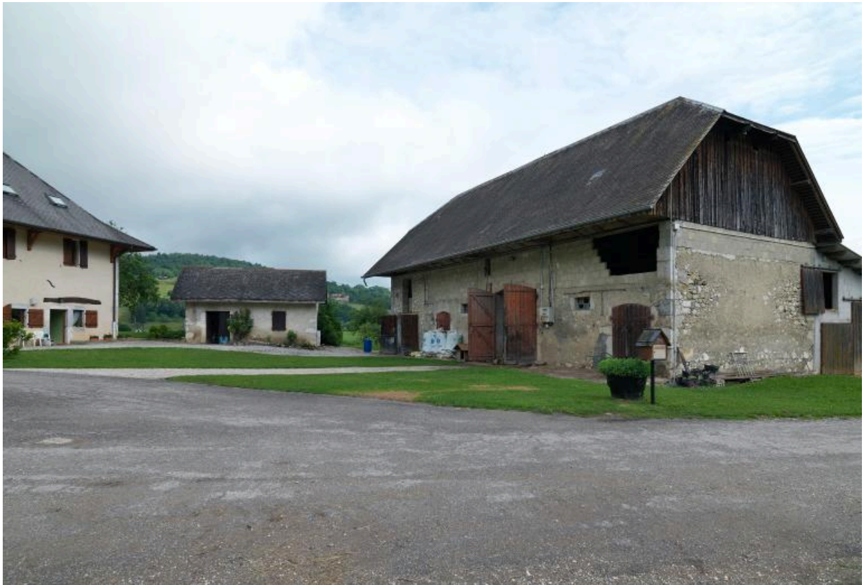
Vue d'ensemble de la grange-étable située à l'est.
