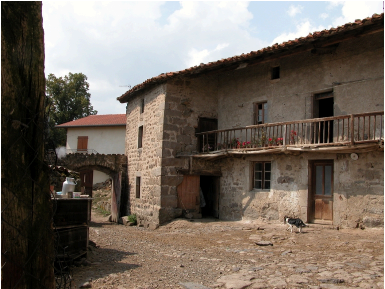
Vue intérieure de la cour : revers du portail, cuvage, partie sud du logis.
