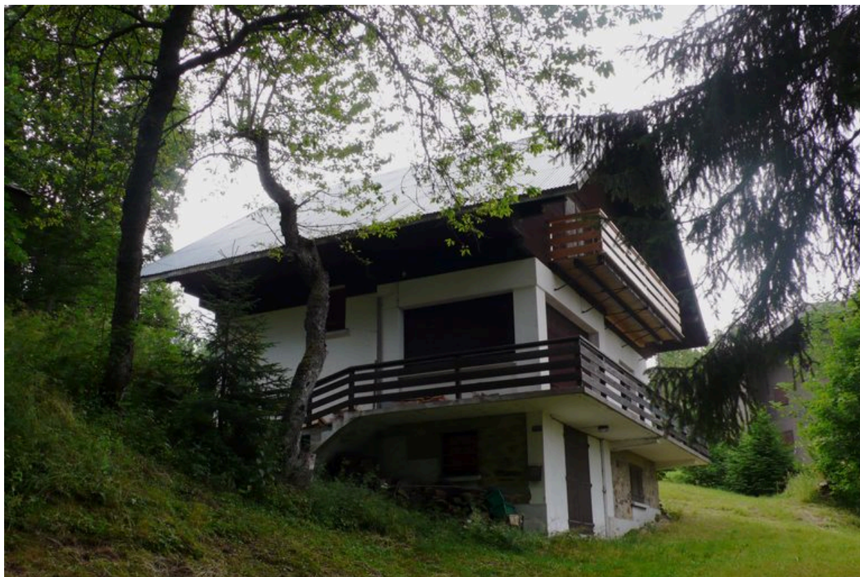
Vue depuis l'ouest
